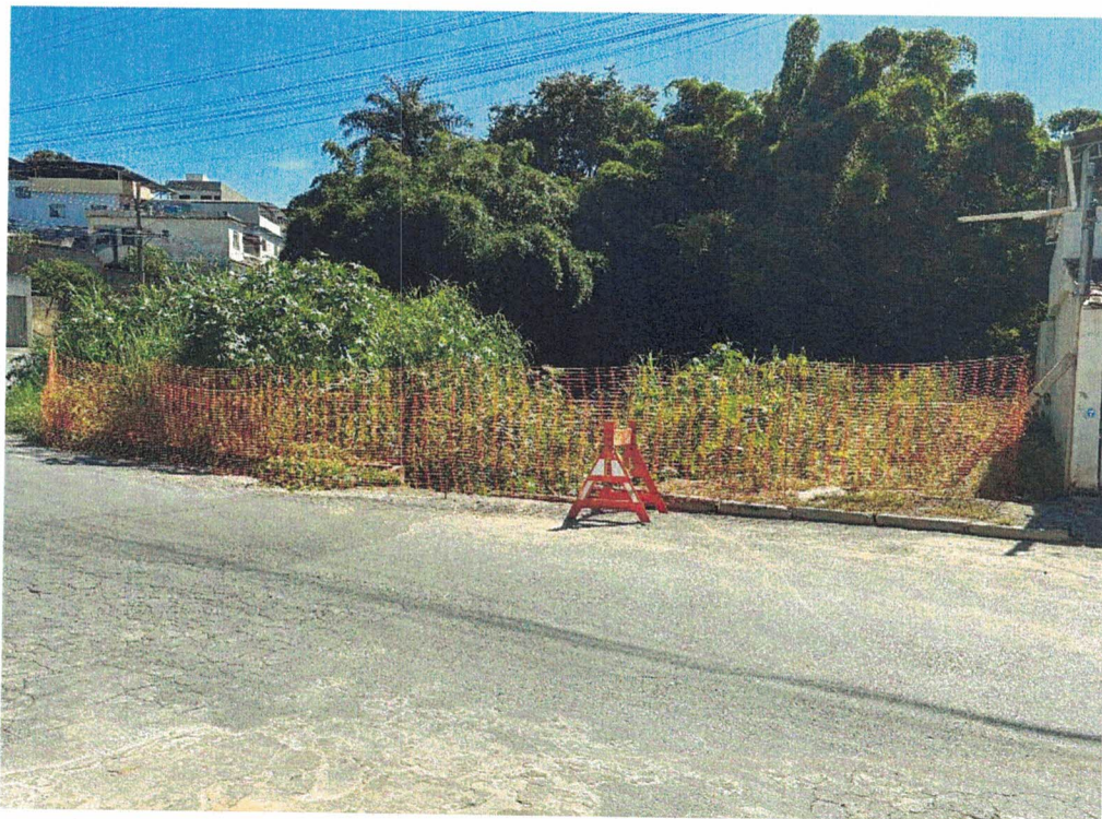
Foto 6 – Isolamento da área com tela tapume.
