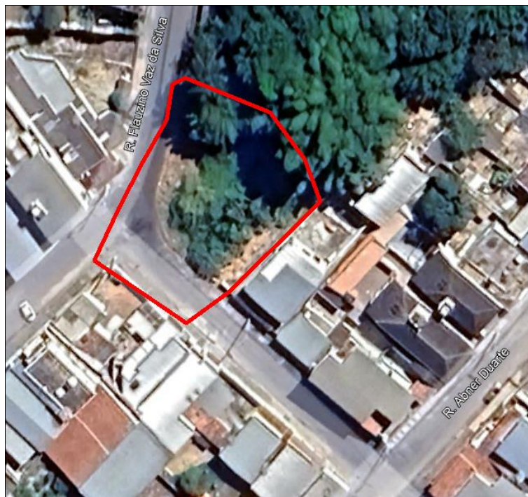
Figura 1 - Vista aérea da localização da ponte
