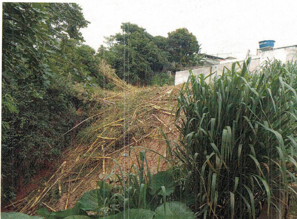
Figura 4 – Aterro realizado sem a devida compactação
