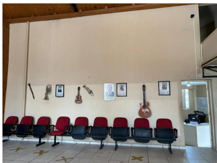
Foto 8 – parede lateral interna do auditório
