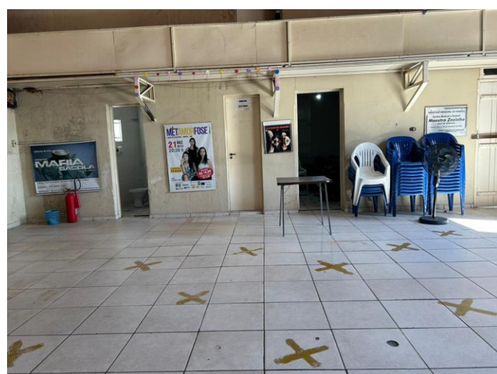
Foto 9 – parede interna do fundo do auditório
