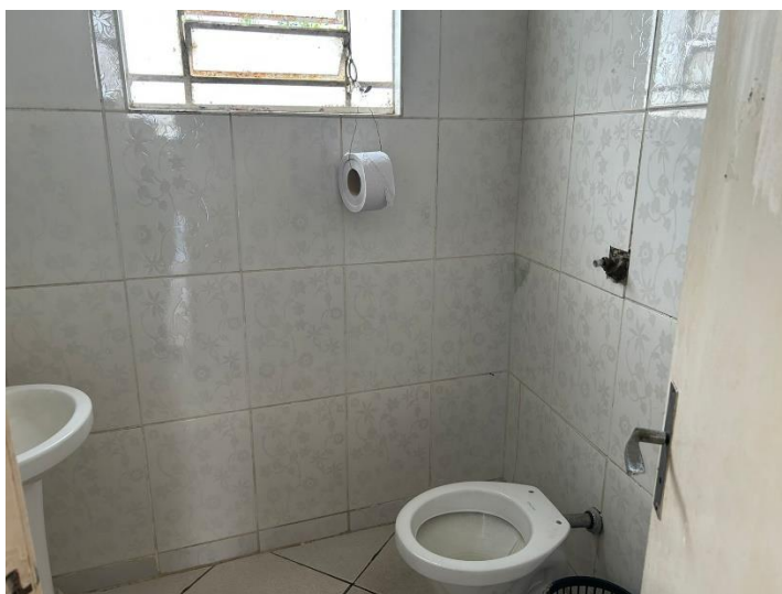
Fotos 19 e 20 - Banheiros
