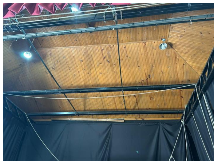
Foto 6 – forro do palco
