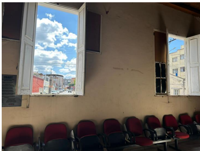
Foto 7 – janelas laterais do auditório
