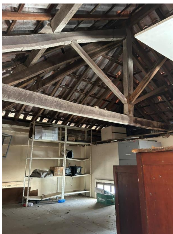
Foto 16 – Telhado da sala 2º andar
