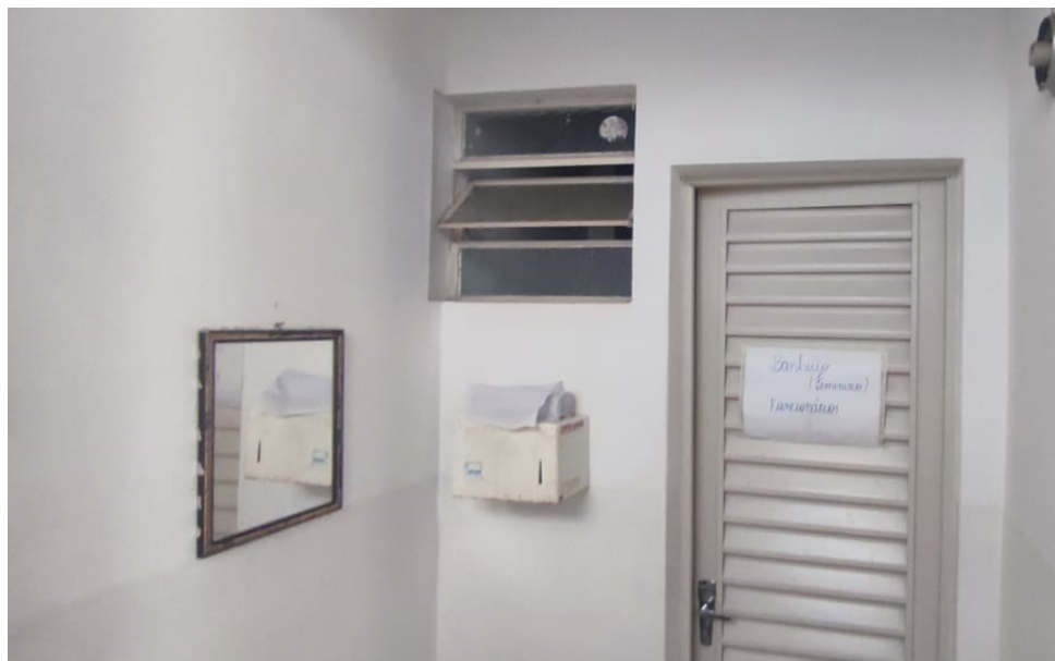
Figura 13 – Corredor de acesso banheiro funcionários.
