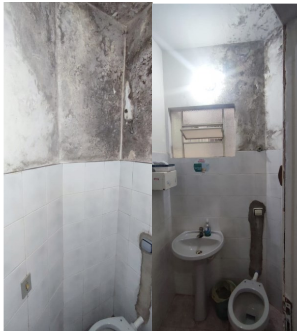
Figura 5 – Banheiro Masculino e Banheiro Feminino
