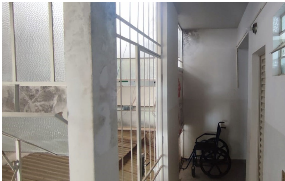
Figura 11 – Corredor de acesso banheiro funcionários
