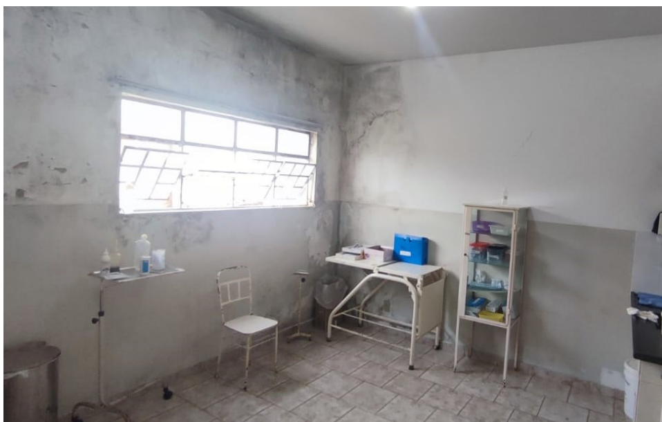
Figura 4 – Sala de curativo.
