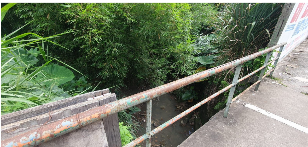
Foto 4 – Vista do Córrego Água Vermelha – rua São Paulo
