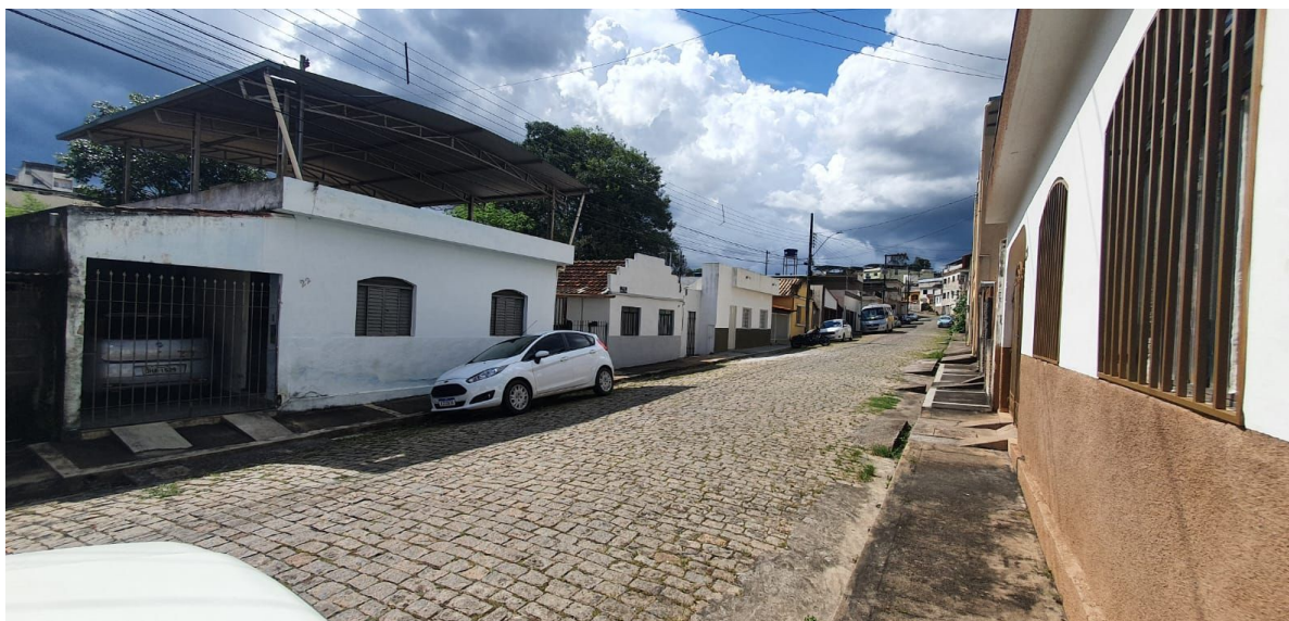
Foto 2 – Córrego Água Vermelha passando aos fundos da Rua Maria José de Faria
