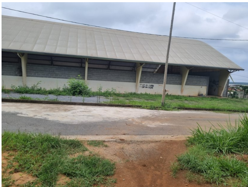
Figura 2 – Local onde será construído o Ponto de Apoio de Saúde da Família
