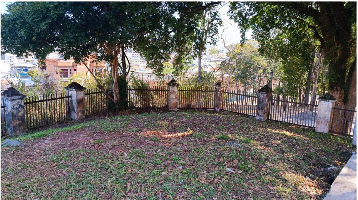
FOTO 8: VISTA DE PARTE DA GRADE EM TORNO DA CASA DO ENGENHEIRO
