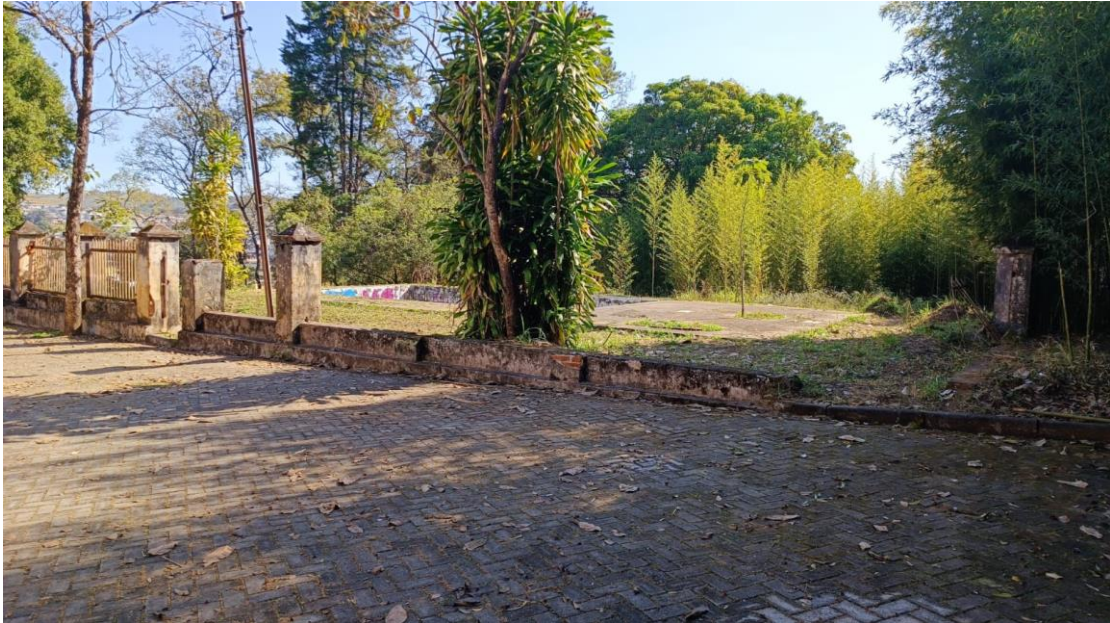
FOTO 9: VISTA DE PARTE DA GRADE
