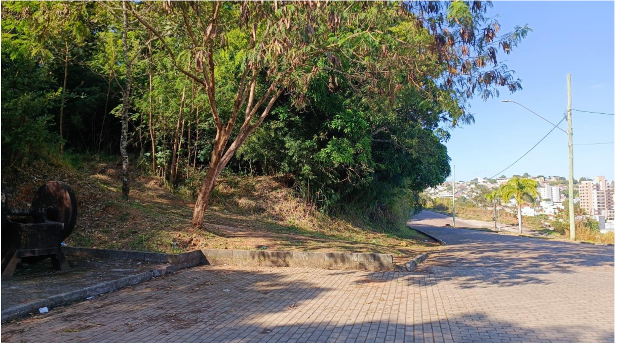
FOTO 3: VISTA DO LOCAL ONDE SERÁ EDIFICADO O MURO PARA INSTALAÇÃO DO PORTÃO
