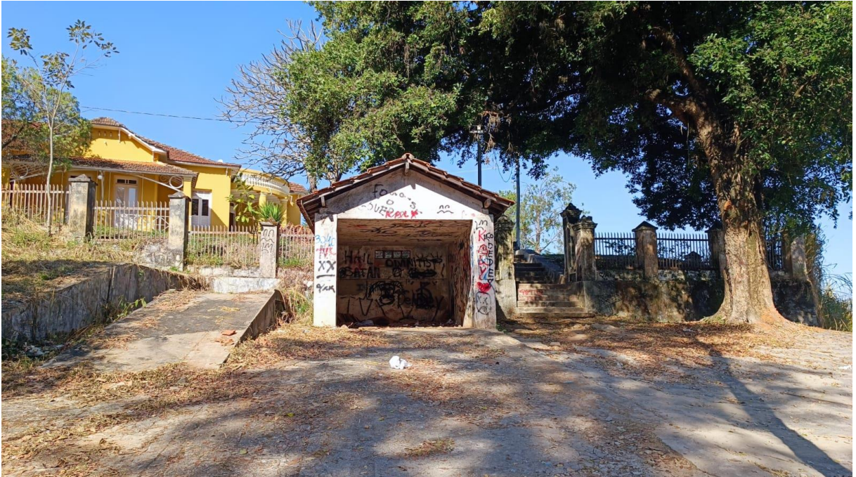
FOTO 11: VISTA DA GARAGEM QUE SERÁ DEMOLIDADA
