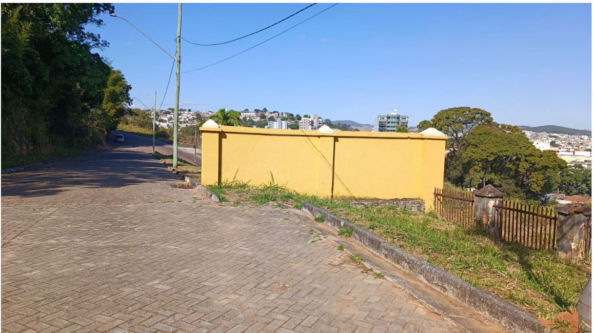
FOTO 4: VISTA DO MURO ONDE SERÁ INSTALADO O PORTÃO
