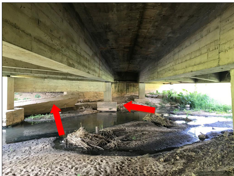
Figura 8. Muro caído e bloco rotacionado.
