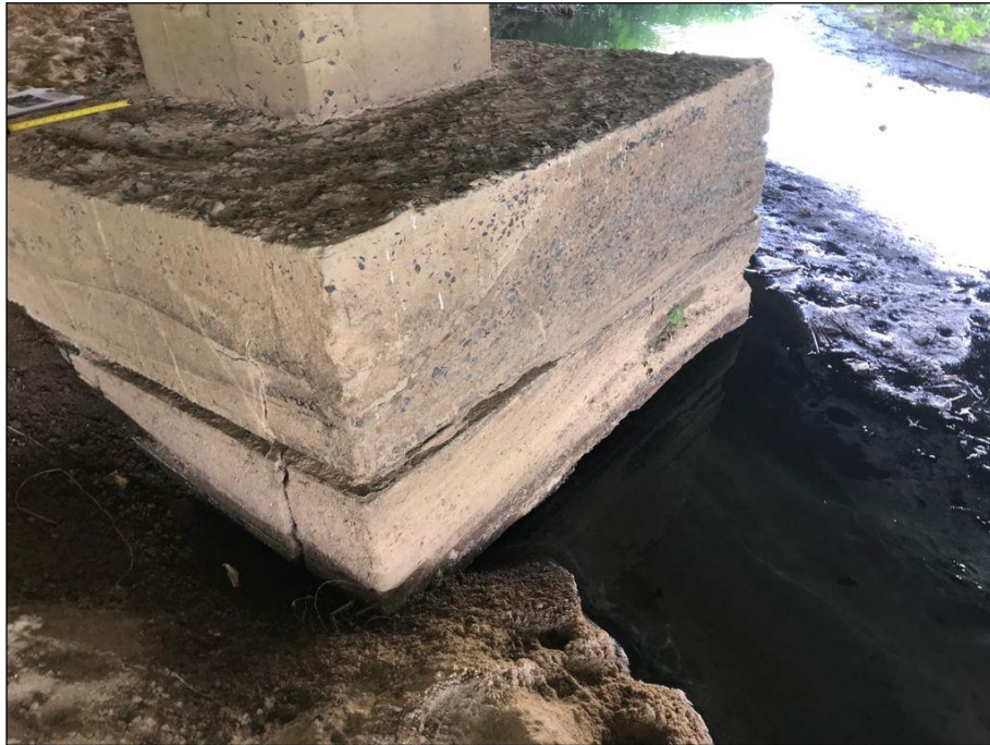
Figura 10. Bloco a proteger (esquerda) e bloco rotacionado.
