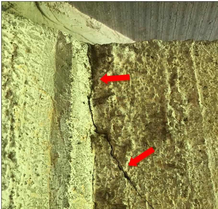
Figura 16 – Trinca de encontro na viga de travamento de topo dos pilares.
