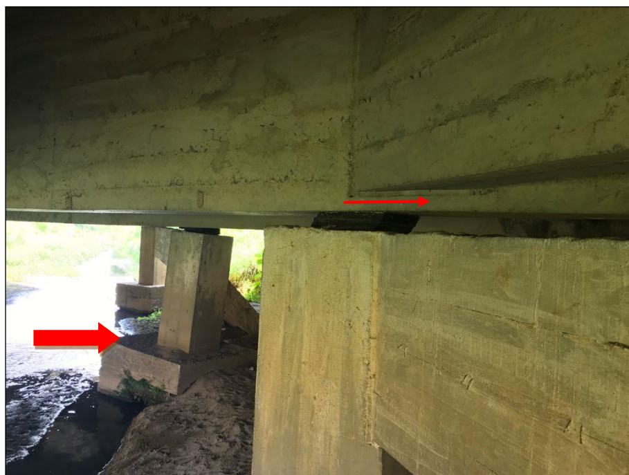
Figura 8. Muro caído e bloco rotacionado.
