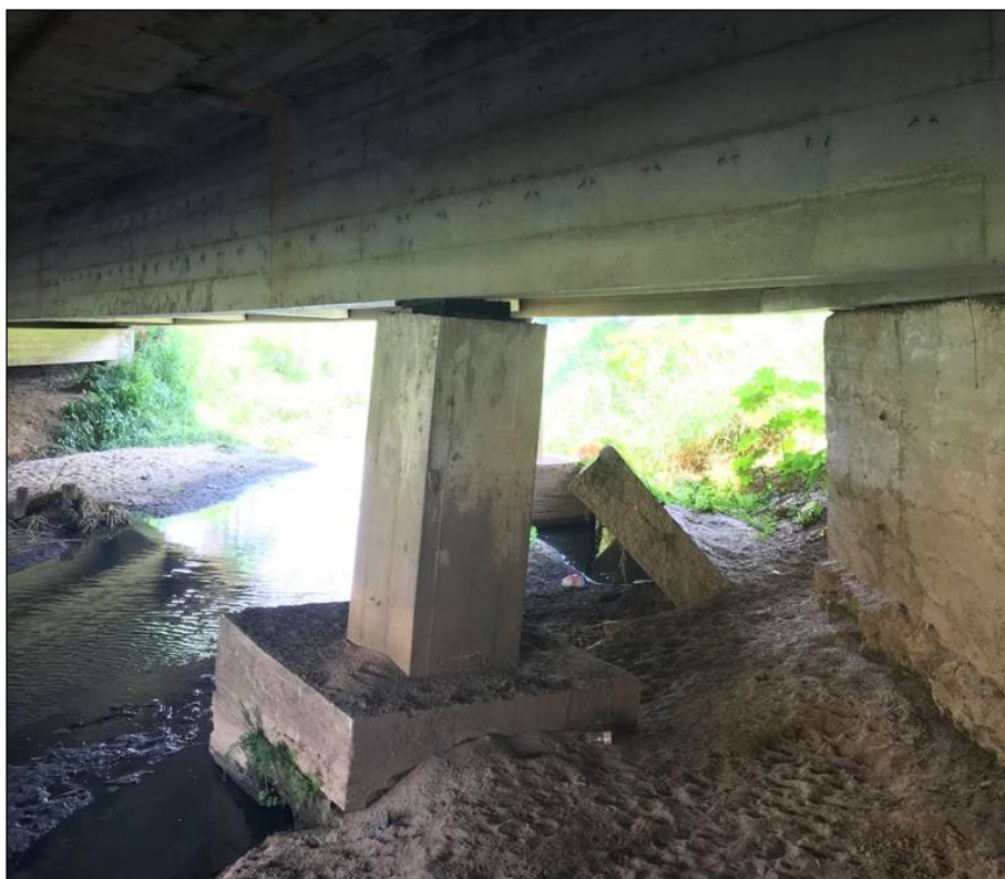
Figura 7. Movimento do Neoprene fretado e pilar rotacionado.
