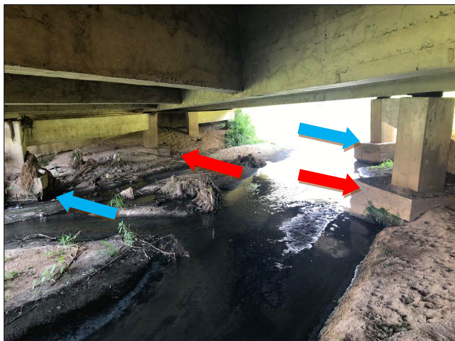
Figura 12. Dois blocos rotacionados a reforçar (vermelho) e a proteger (azul)
