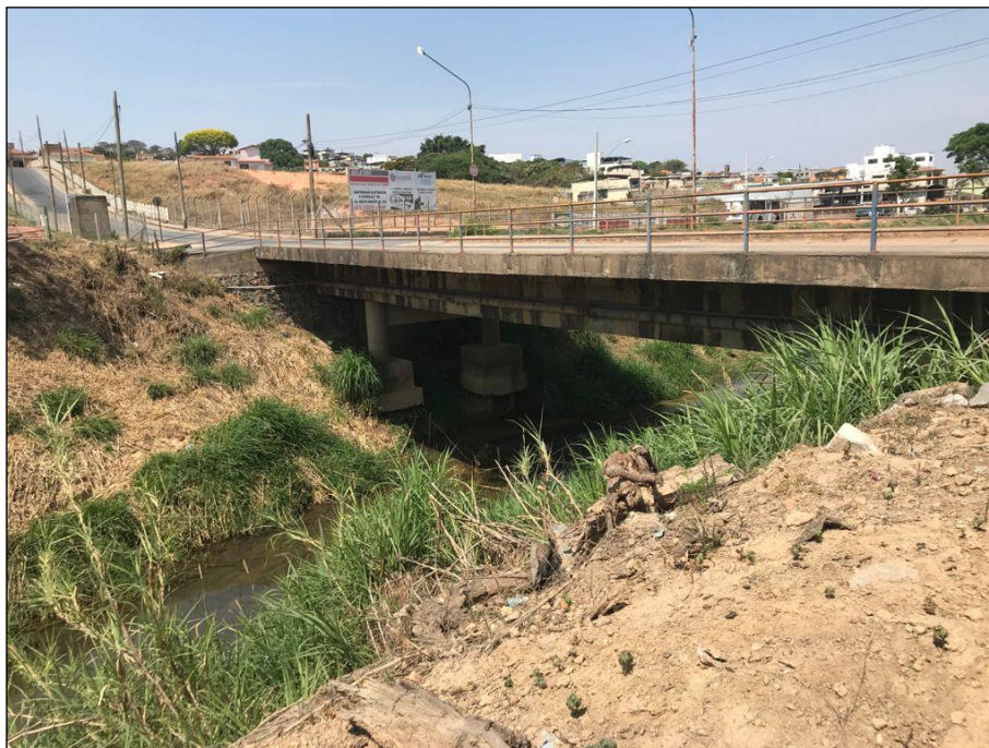
Figura 4. Erosão abaixo dos blocos de fundação e vigas metálicas de suporte.
