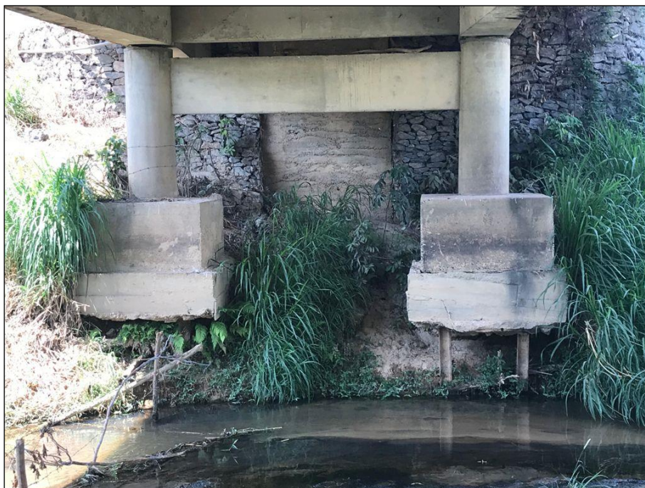
Figura 4. Erosão abaixo dos blocos de fundação e vigas metálicas de suporte.
