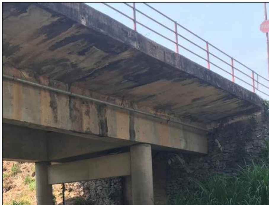
Figura 6. Sinais de escoamento de água e deterioração do concreto.
