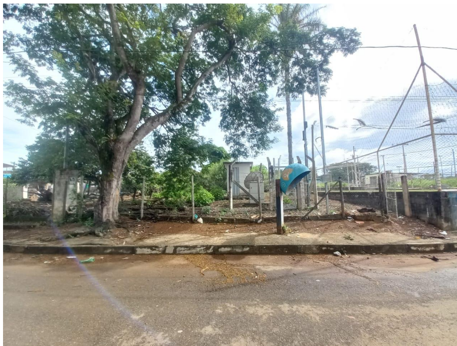
Figura 1 - Vista frontal do terreno que vai ser construído o Velório Municipal de Ponte Vila
