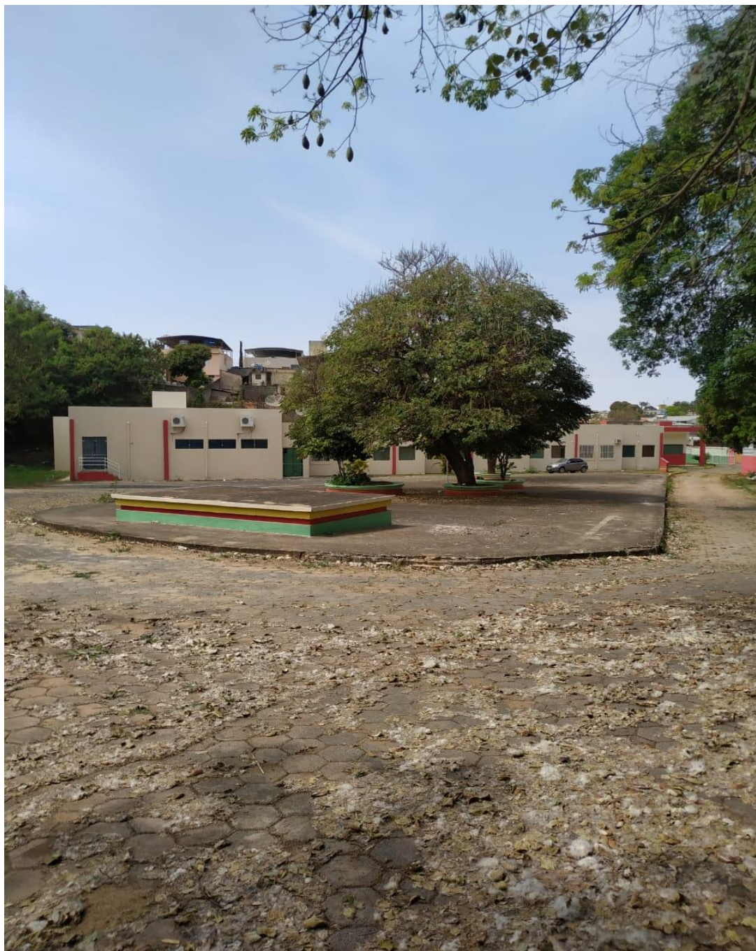
FOTO 6: VISTA POSTERIOR DO CEMAP - SETOR DE PROJETOS ESTRUTURAIS.
