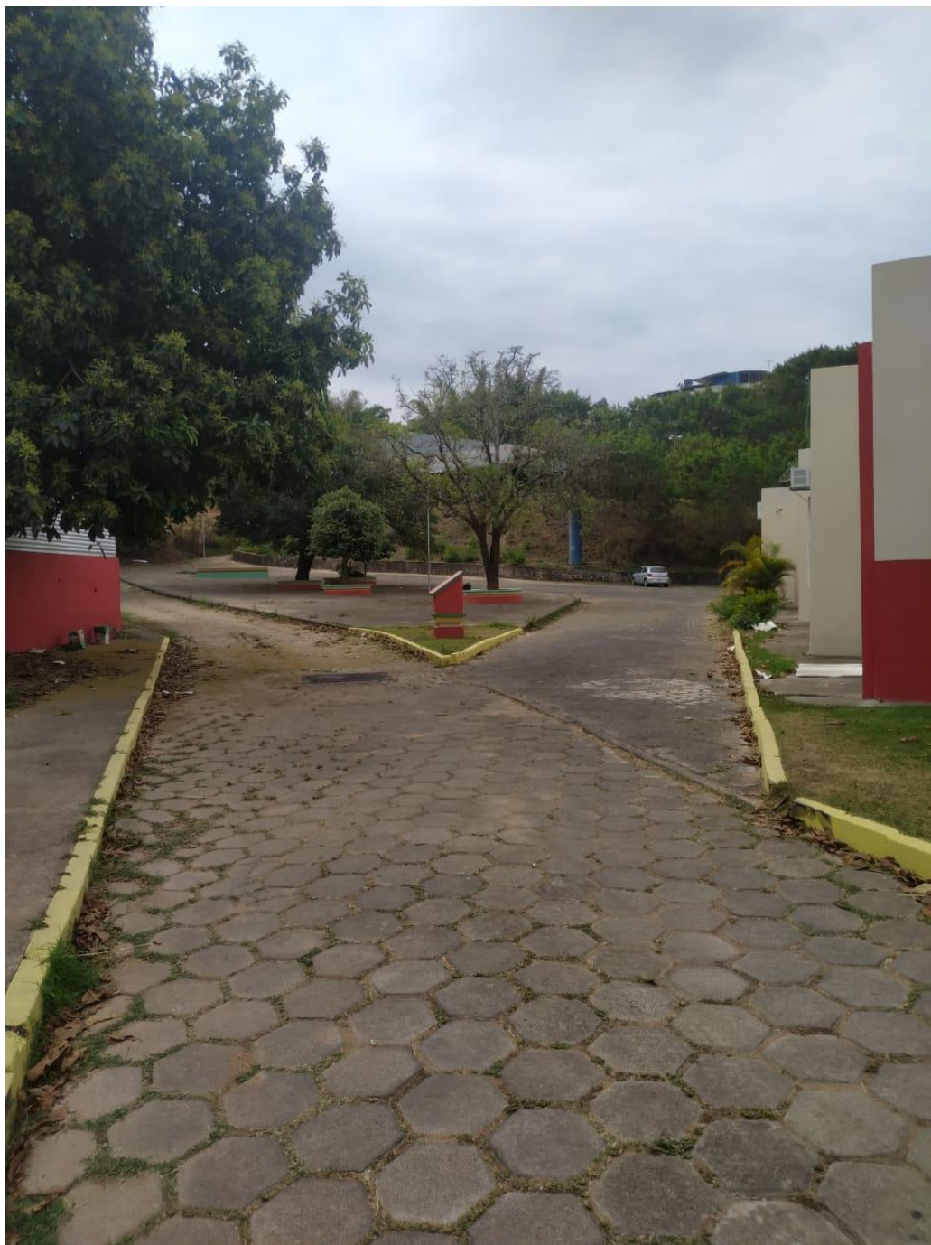
FOTO 3: VISTA DO ACESSO PARA A RUA PROFESSOR AUGUSTO BARBOSA AO LOCAL ONDE SERÁ EDIFICADO O PROJETO - SETOR DE PROJETOS ESTRUTURAIS.
