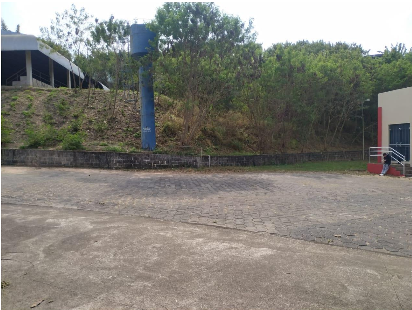
FOTO 5: VISTA POSTERIOR DO CEMAP - SETOR DE PROJETOS ESTRUTURAIS.
