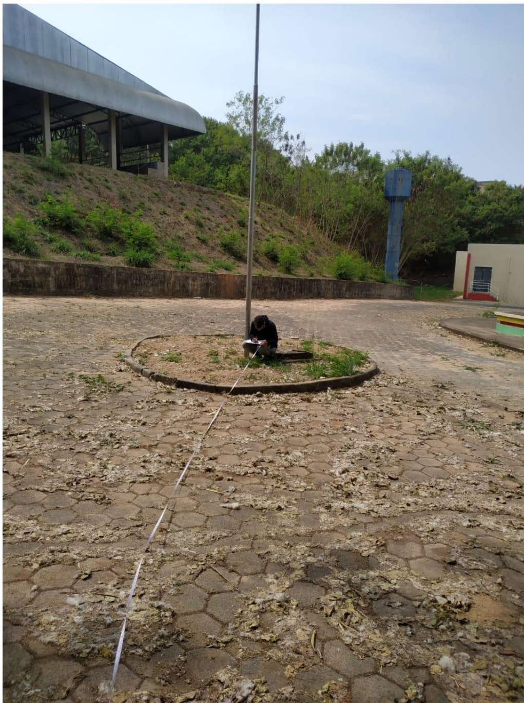
FOTO 8: VISTA POSTERIOR DO CEMAP - SETOR DE PROJETOS ESTRUTURAIS.
