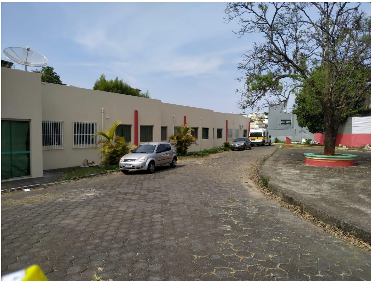
FOTO 7: VISTA LATERAL DIREITA DO CEMAP - SETOR DE PROJETOS ESTRUTURAIS.
