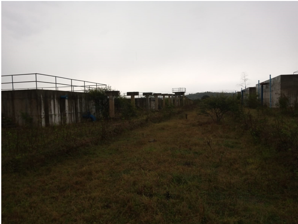
Foto 2 – Vista dos Aeradores e CDV 2
