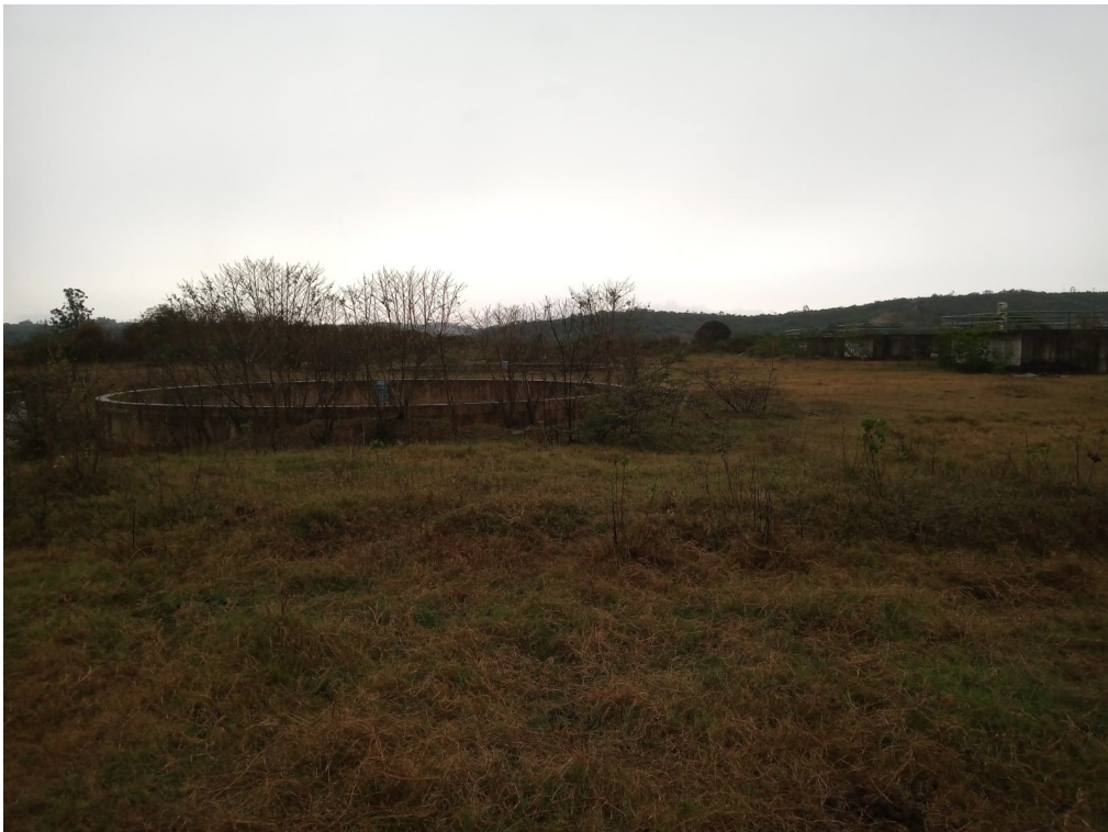
Foto 4 – Vista de um Decantador Secundário
