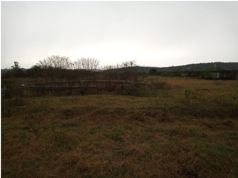
Foto 4 – Vista de um Decantador Secundário
