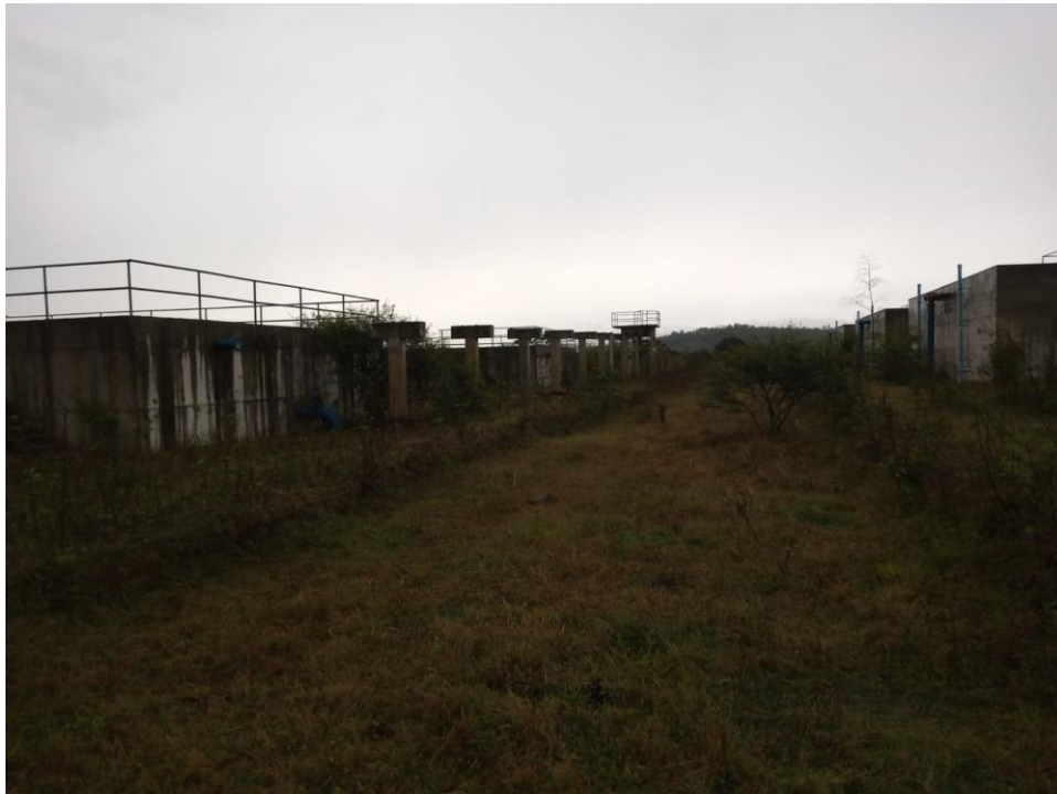
Foto 2 – Vista dos Aeradores e CDV 2
