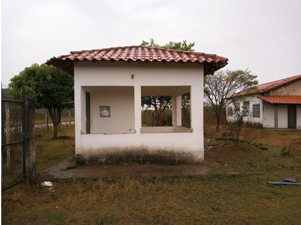
Vista 5 – Vista da Guarita e da Casa de Controle
