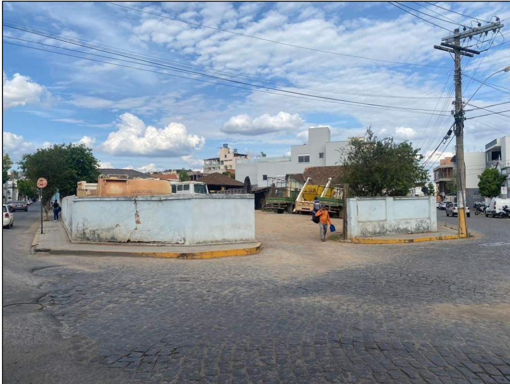
Figura 3 – Vista do encontro com a Rua Doutor Newton Pires
