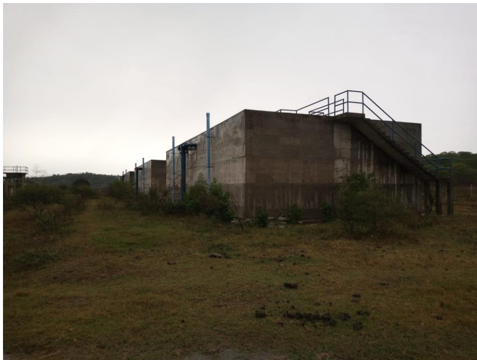
Foto 1 – Vista dos Reatores.
