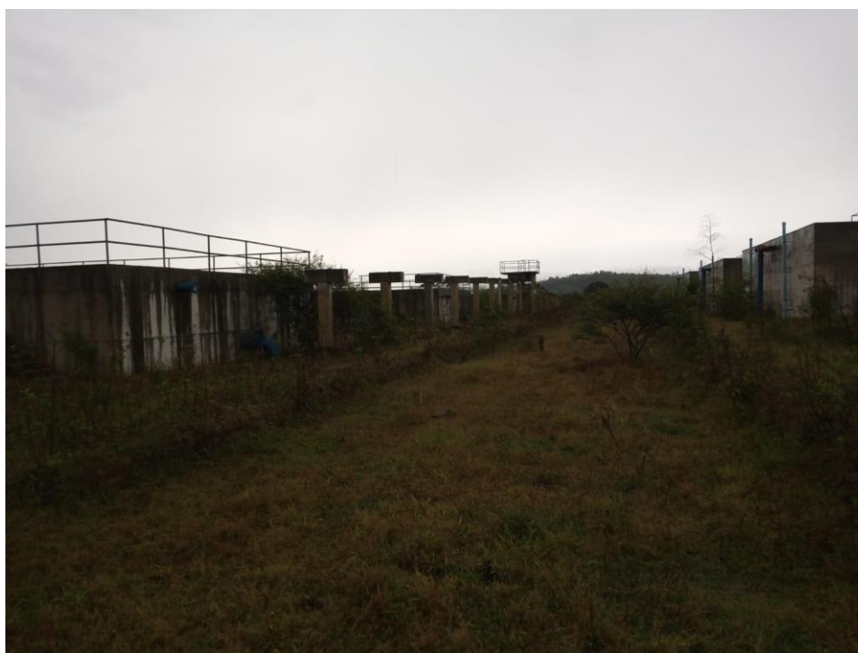
Foto 2 – Vista dos Aeradores e CDV 2
