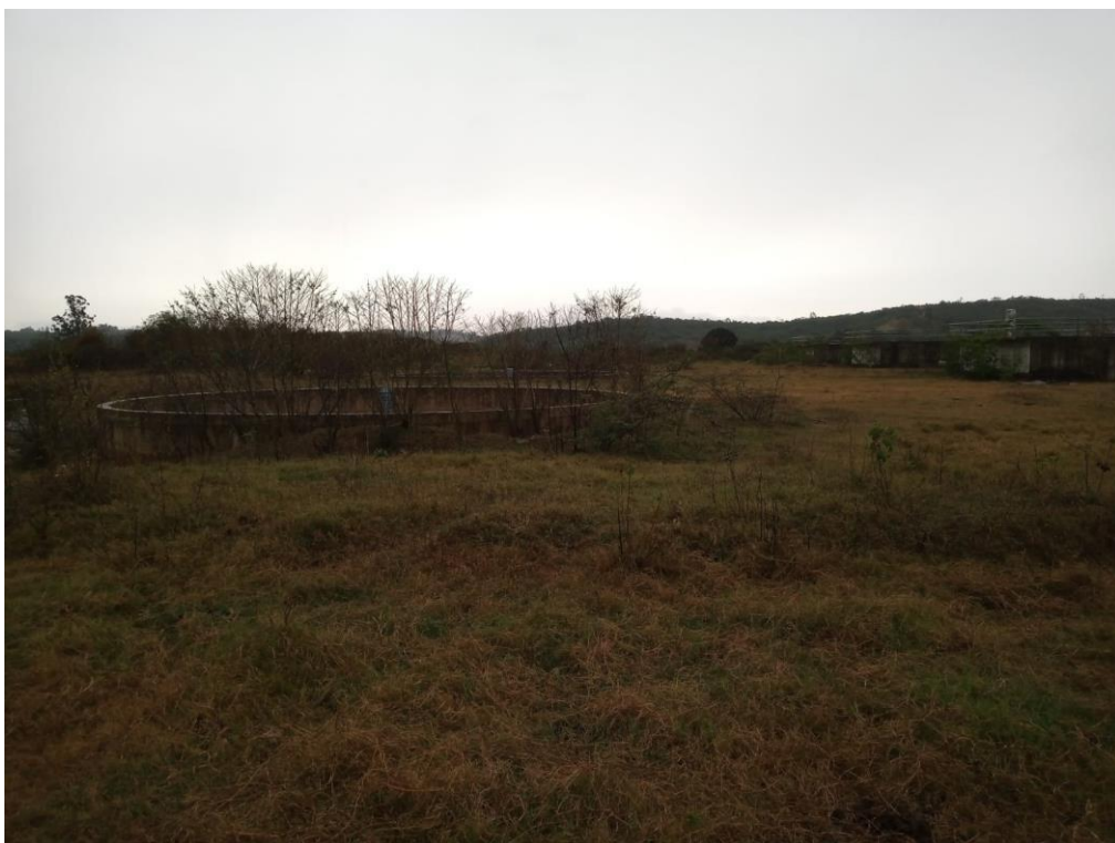
Foto 4 – Vista de um Decantador Secundário
