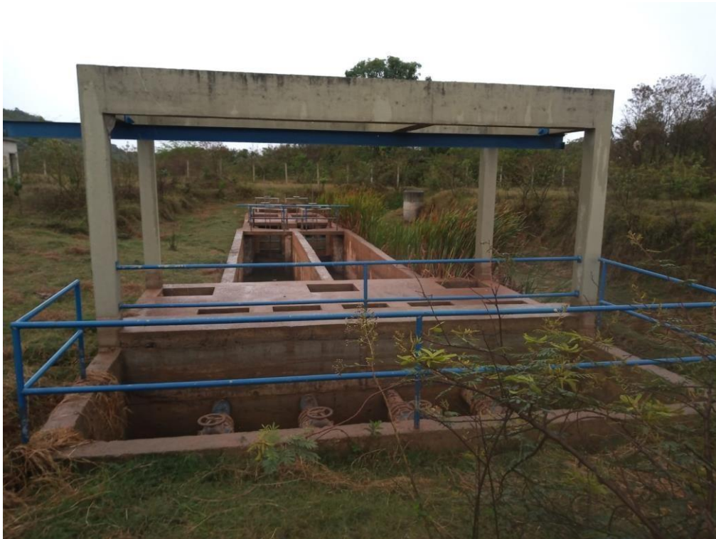
Foto 3 – Vista da Estação Elevatória Final e do Tratamento Preliminar
