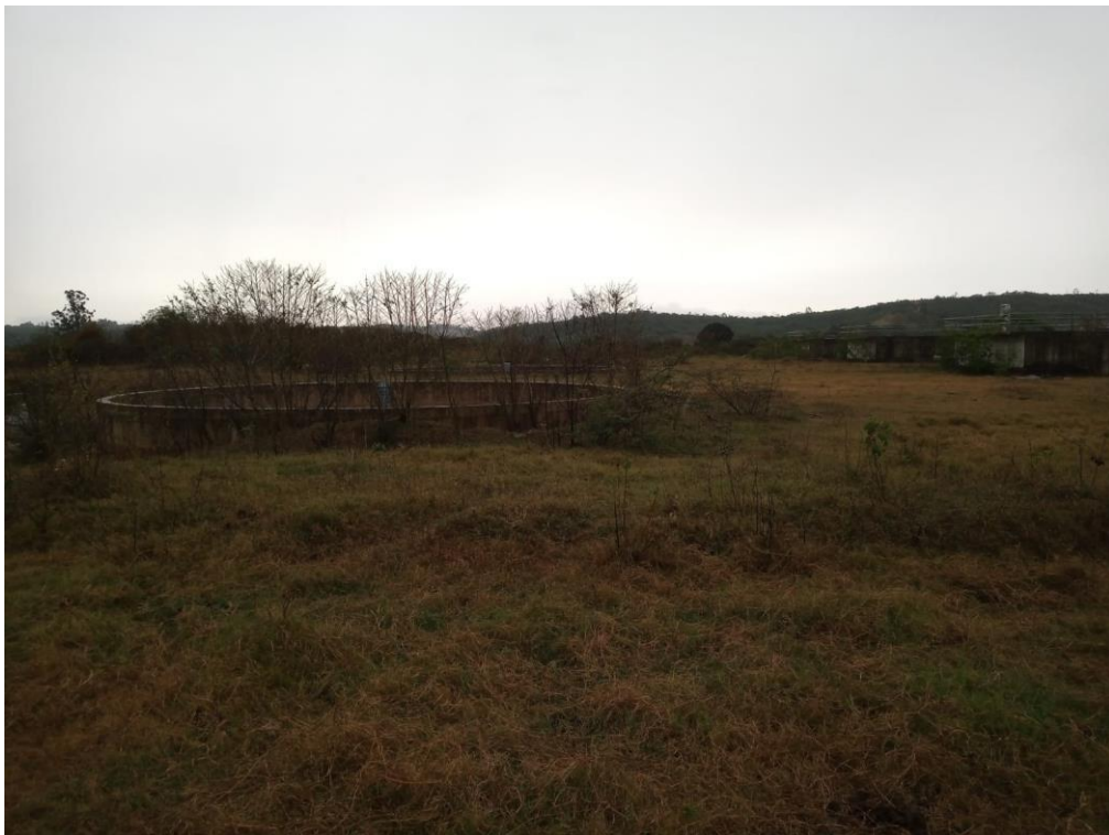
Foto 4 – Vista de um Decantador Secundário
