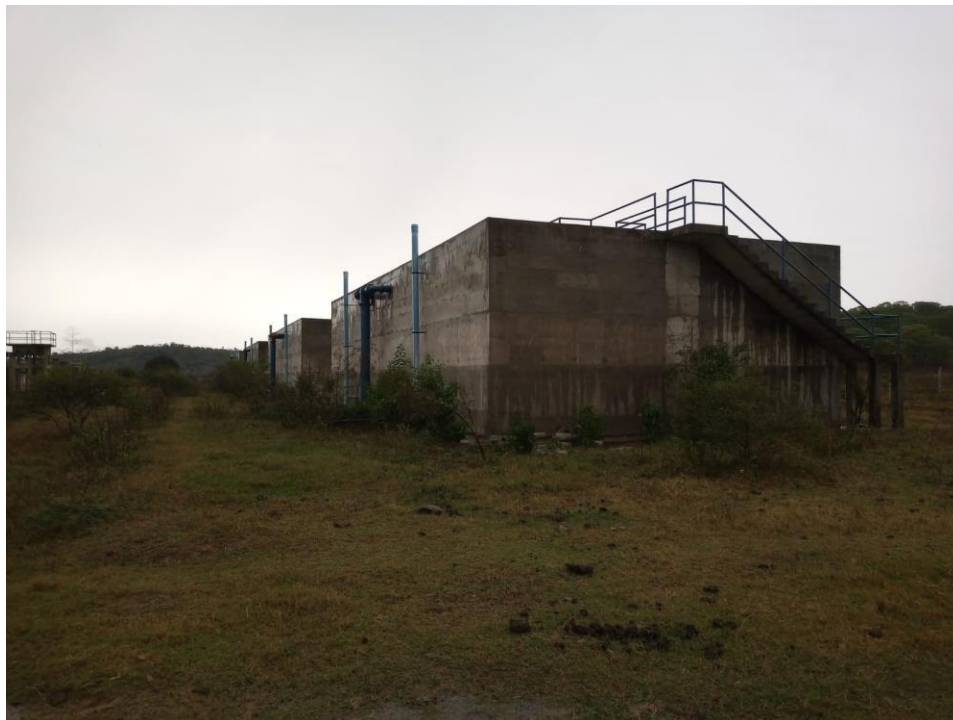
Foto 1 – Vista dos Reatores.
