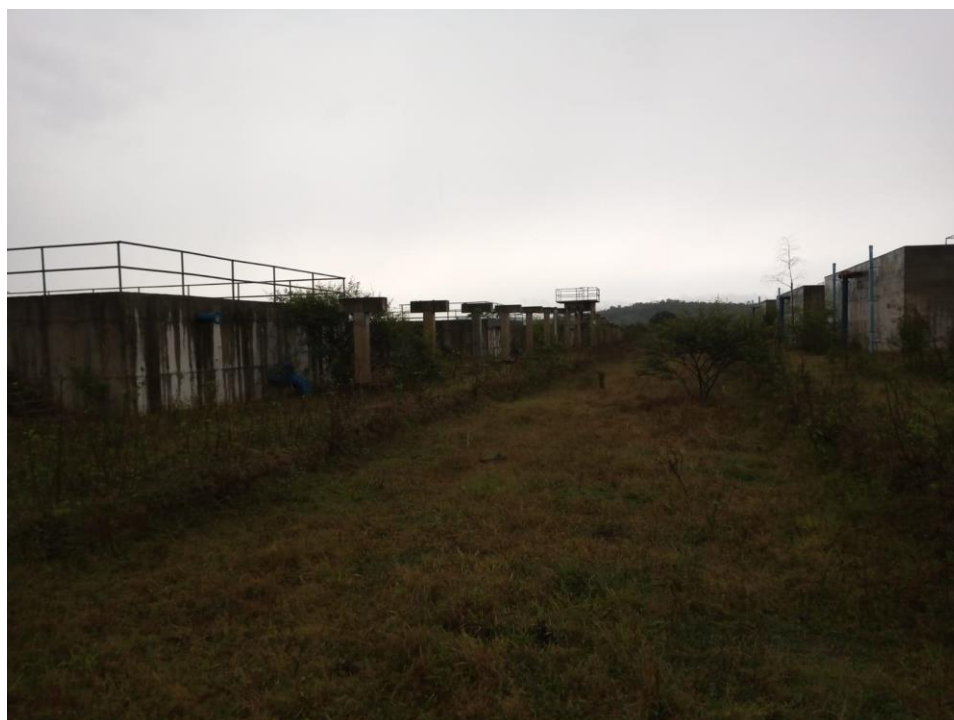
Foto 2 – Vista dos Aeradores e CDV 2
