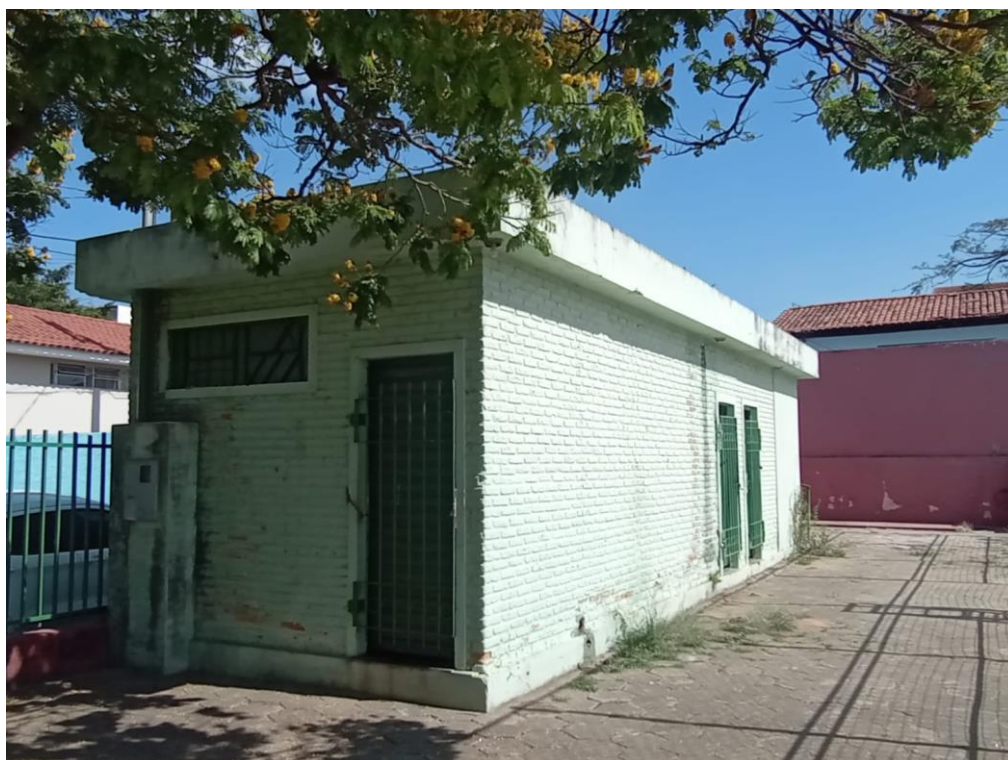
Foto 4 – Vista do vestiário a ser reformado
