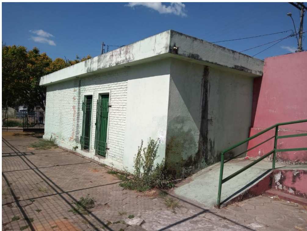
Foto 5 – Vista do vestiário
