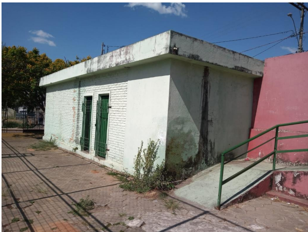
Foto 5 – Vista do vestiário
