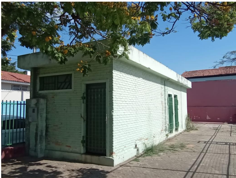
Foto 4 – Vista do vestiário a ser reformado
