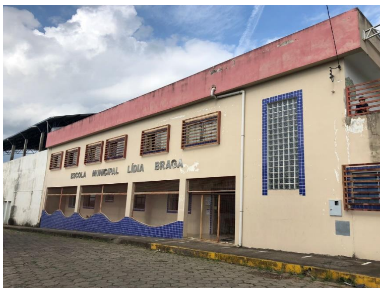
Imagem 1 - Fachada principal Escola Municipal Lídia Braga Rua Gislene Aparecida Mendonça.
