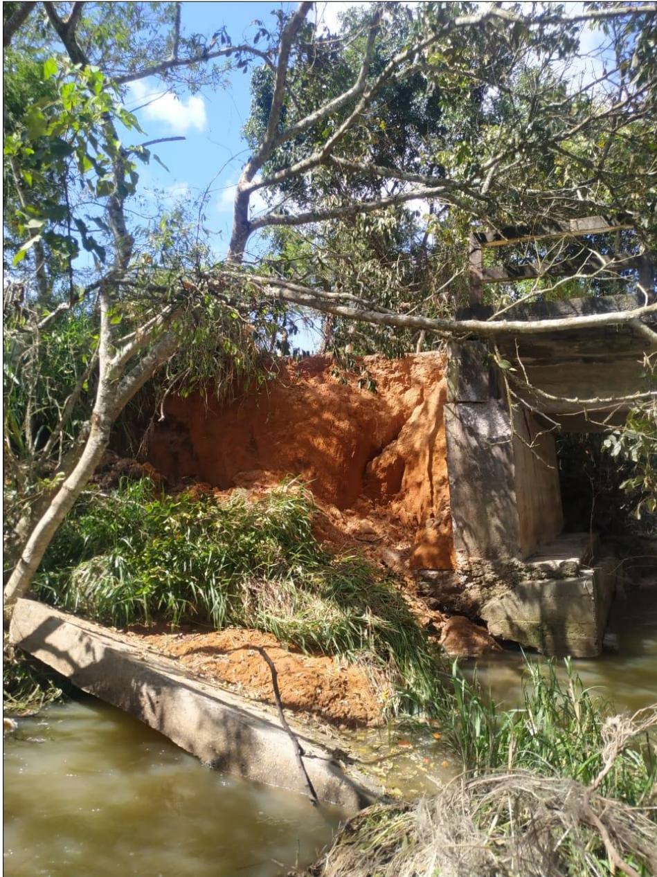
Figura 9. Vista da estrutura em concreto para contenção do solo que se encontra no leito do corpo hídrico.
