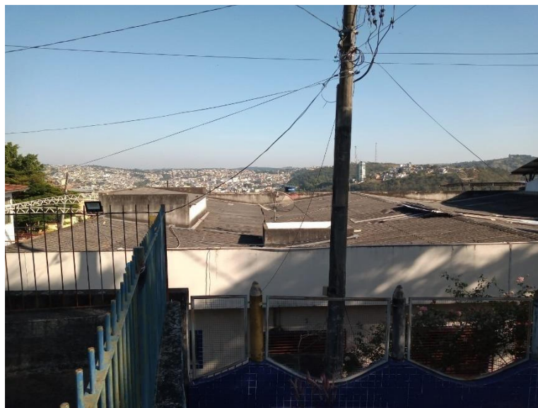
Imagem 5 – Telhado existente em telha amianto.
