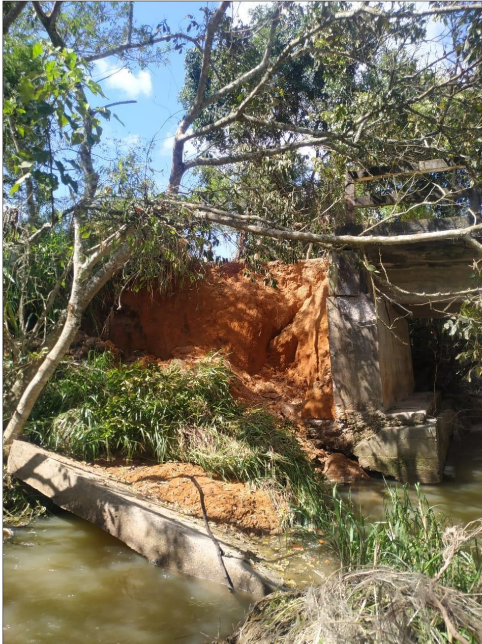
Figura 9. Vista da estrutura em concreto para contenção do solo que se encontra no leito do corpohídric
