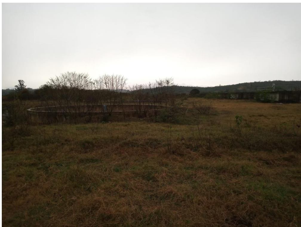
Foto 4 – Vista de um Decantador Secundário
