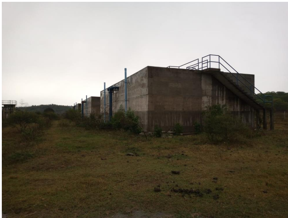
Foto 1 – Vista dos Reatores.
