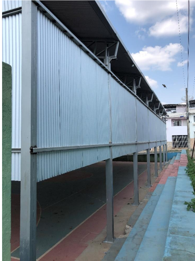
Foto 05 – Lateral superior da quadra.
