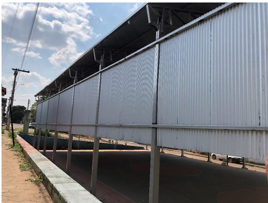
Foto 06 – Vista exterior da estrutura.
