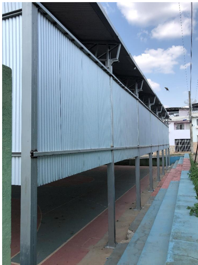
Foto 05 – Lateral superior da quadra.
