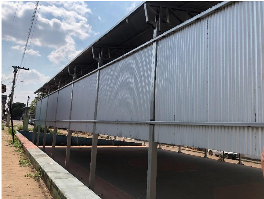
Foto 06 – Vista exterior da estrutura.
